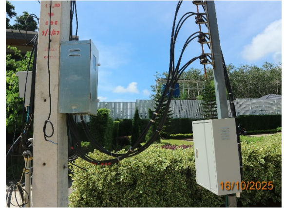
รูปที่ 3.1-26 อุปกรณ์ตัดไฟฟ้าอัตโนมัติ
