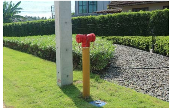
รูปที่ 3.1-37 หัวรับน้ำดับเพลิงภายในโครงการ
